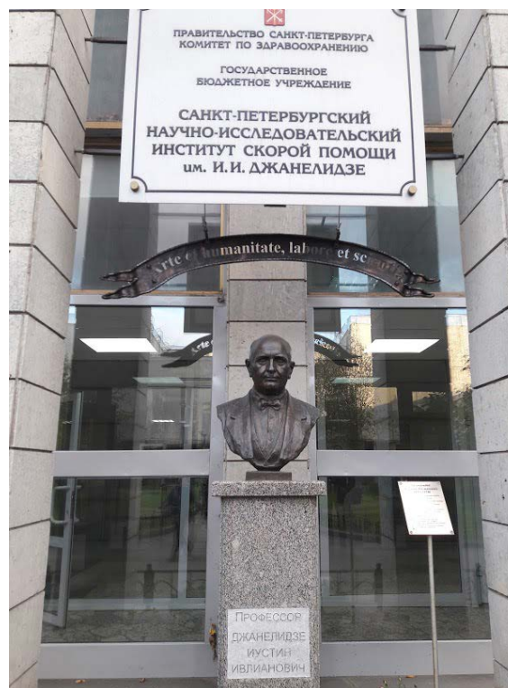
Рис. 10. Современный вид СПб НИИ Скорой помощи им. И.И. Джанелидзе (центральный вход)
